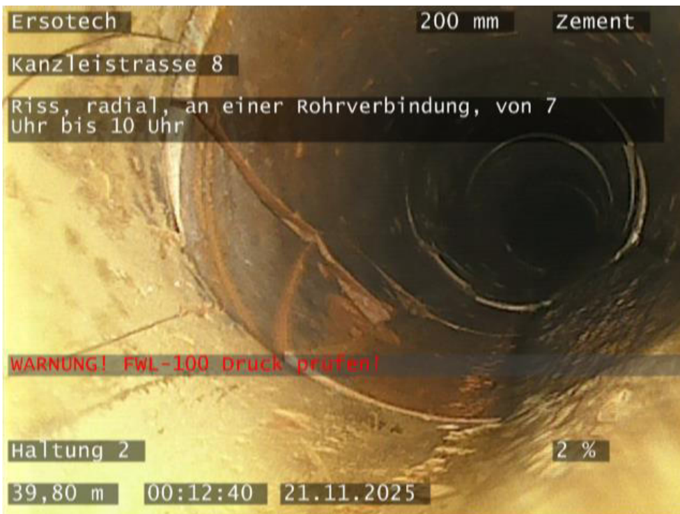
Foto: #28 Entfernung: 39,80 m Kürzel: BABBB Riss, radial, an einer Rohrverbindung, von 7 Uhr bis 10 Uhr
