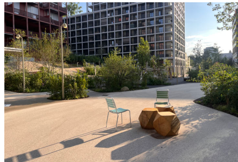
Farbasphalt mit Oberflächenbearbeitung Kleweg-Verfahren - Eichhof West, Kriens
